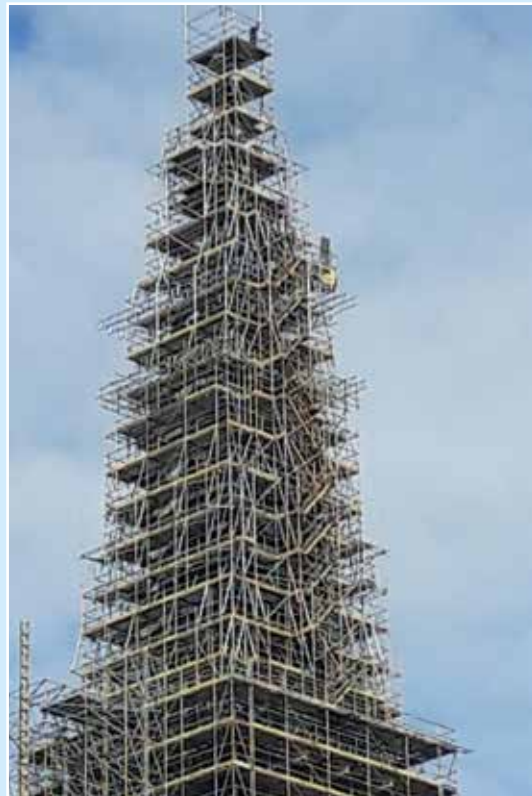
St.-Petri-Dom - Die noch immer eingerüstete Turmspitze
